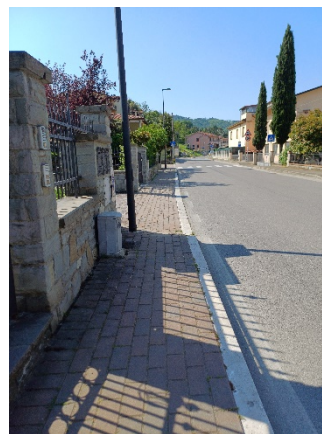
Via Giotto – lato Est (residuo marciapiede per illuminazione = 1,00 m)
