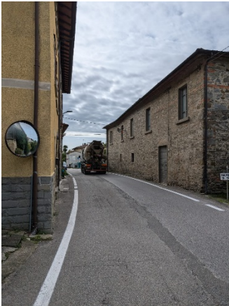
Loc. Castelnuovo - lato Est
