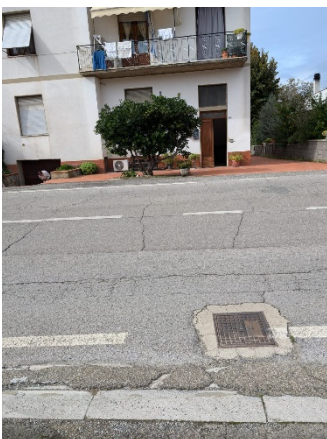
Loc. Castelnuovo – attraversamento zona Sud
