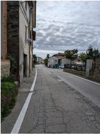
Loc. Castelnuovo - lato Est
