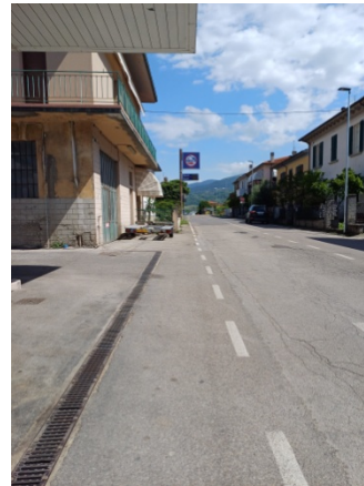
Via Verdi - lato Ovest
