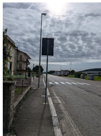
Loc. Castelnuovo - lato Ovest
