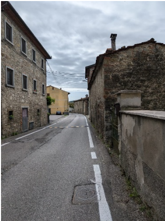
Loc. Castelnuovo - lato Ovest
