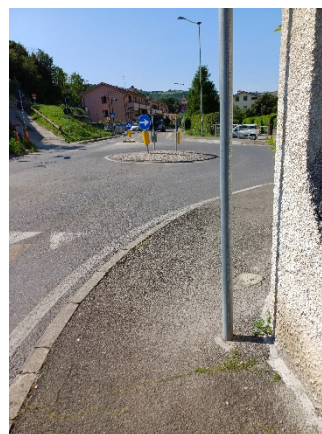
Via Giotto – lato Ovest (residuo marciapiede per cartello stradale = 1,00 m)
