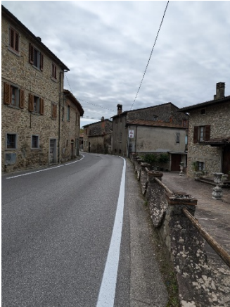
Loc. Castelnuovo - lato Ovest
