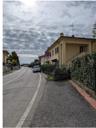
Loc. Castelnuovo - lato Ovest
