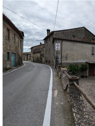
Loc. Castelnuovo - lato Ovest
