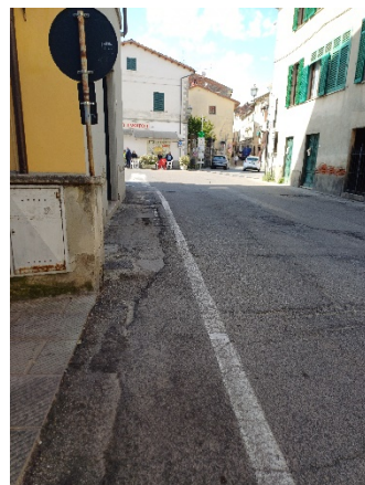
Via Verdi – lato Est
