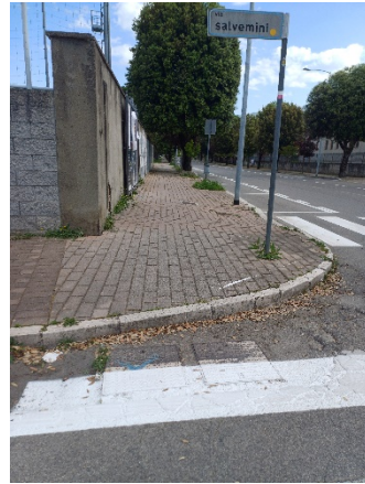
Via Verdi - lato Est
