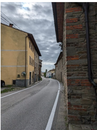
Loc. Castelnuovo - lato Ovest
