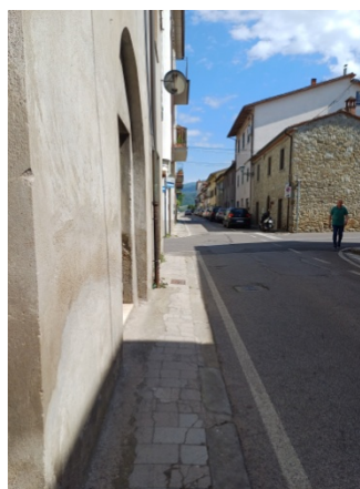
Via Verdi - lato Ovest
