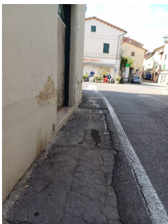
Via Verdi - lato Est
