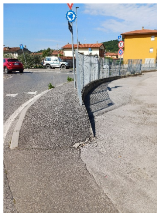
Via Marconi – lato Ovest (residuo marciapiede per cartello stradale = 1,00 m)
